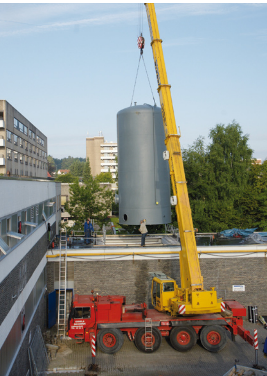
Millimeterarbeit: Durch das geöffnete Dach wird der Wasserspeicher herabgelassen.
